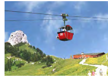
KAMPENWAND CABLE CAR www.kampenwand.de
