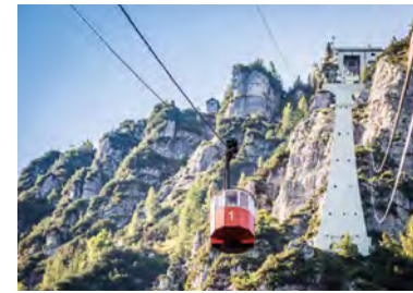
PREDIGTSTUHL CABLE CAR, BAD REICHENHALL www.predigtstuhlbahn.de
